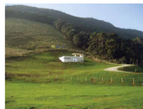
Cámara de carga del emisario submarino de Berri
